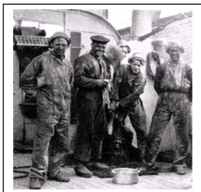
Kullempning var beskidt arbejde
